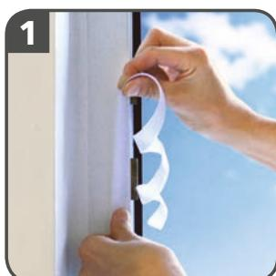
Ouvrir la fenêtre. Nettoyer la surface de l'encadrement et du battant de fenêtre pour enlever la poussière et d'éventuels dépôts gras. Coller les bandes auto-agrippantes (**côté A**) sur l'encadrement.
