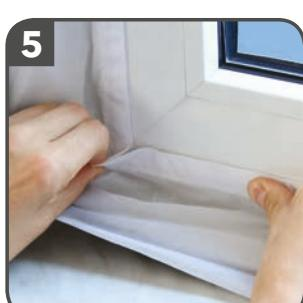
De smalle **kant B** (ritssluiting blijft dicht) van het midden naar links en rechts, respectievelijk naar boven en beneden volledig aan het raamvleugel vast maken.
