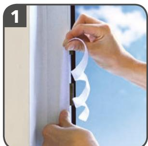
Aprire la finestra e pulire per bene l'anta e il telaio della finestra dove applicare la guarnizione, eliminando polvere e grasso. Aprire la chiusura a strappo e far aderire il nastro adesivo (**lato A**) al telaio della finestra.
