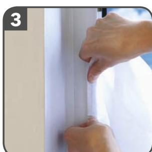
Eerst de brede **kant A** (ritssluiting blijft dicht) bij geopend raam vanaf het midden naar links en rechts, respectievelijk naar boven en beneden volledig aan het kozijn vast maken.
