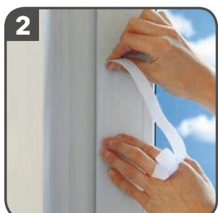
Attaccare il nastro adesivo (**lato B**) sul lato **a**) esterno o **b**) interno dell'anta della finestra (lato con la maniglia).
